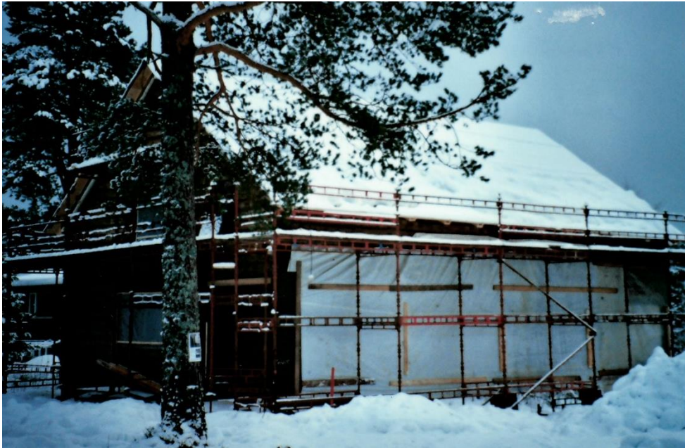
Huset med midlertidig lett tak skal stå å side ein vinter
