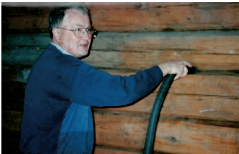
Leidulv Stokkeland støvsugar veggjar etter pussing.
